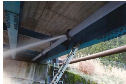
橋下部配水管からの漏水 (2018年 豊岡市内)
