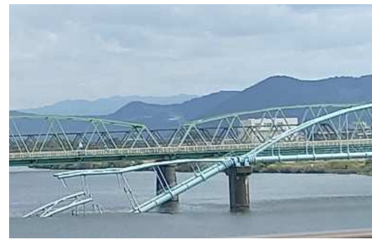
和歌山市の水管橋崩落事故 (2021年 給水応援派遣時に撮影)
