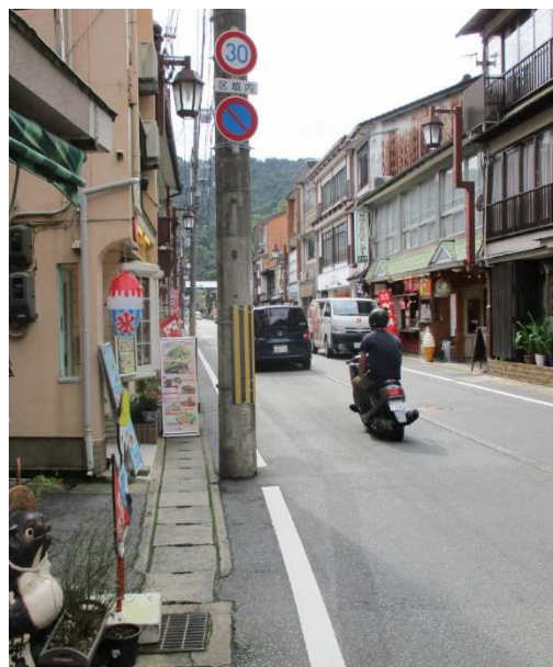
<湯の里通りの電柱の状況>
