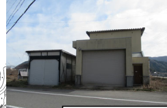
除雪機械車庫
