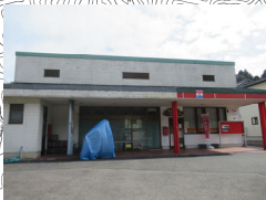
倉庫 (元JA轟支店)
