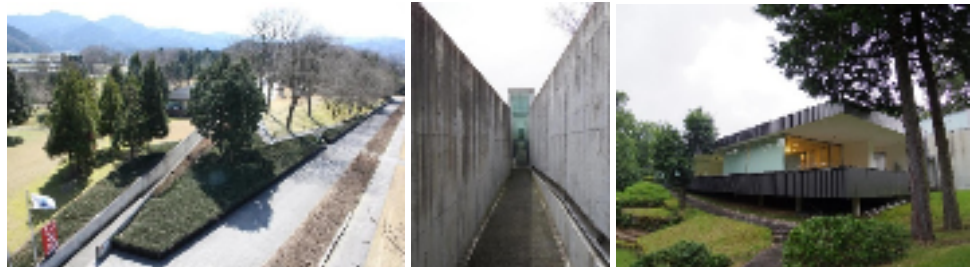
写真:(左)冒険館を北東側より俯瞰 (中)クレパスをイメージした導入部は躯体の汚れが目立つ (右)新館
