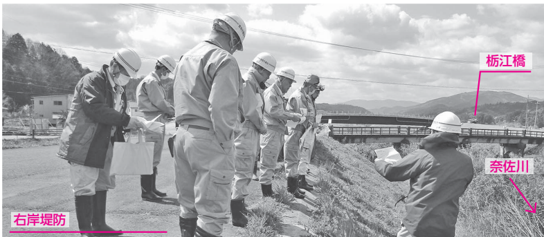
福田地内ブロック張復旧箇所
