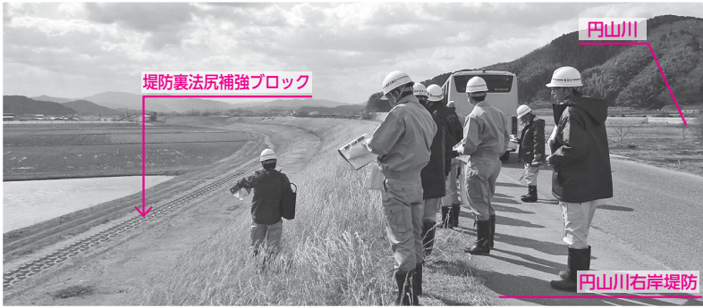
赤石地内堤防裏法尻補強箇所
