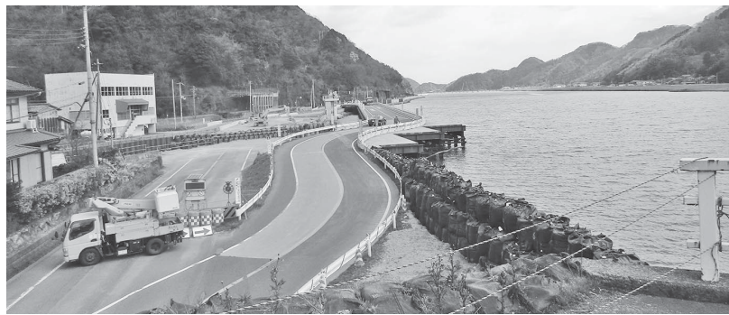
来日川合流部工事状況
