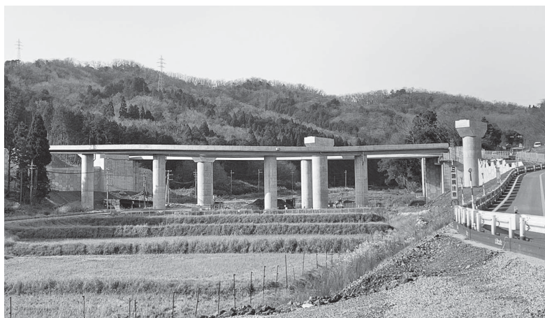
一日も早い供用開始を! 北近畿豊岡自動車道 (仮称)豊岡南IC (上佐野地内)
