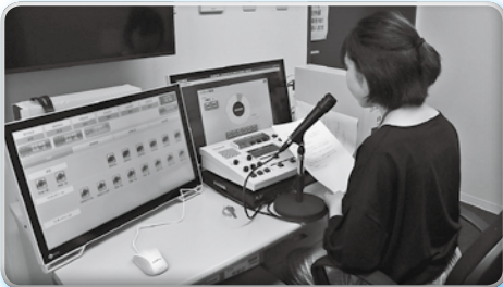
▲デジタル防災行政無線の放送機器
