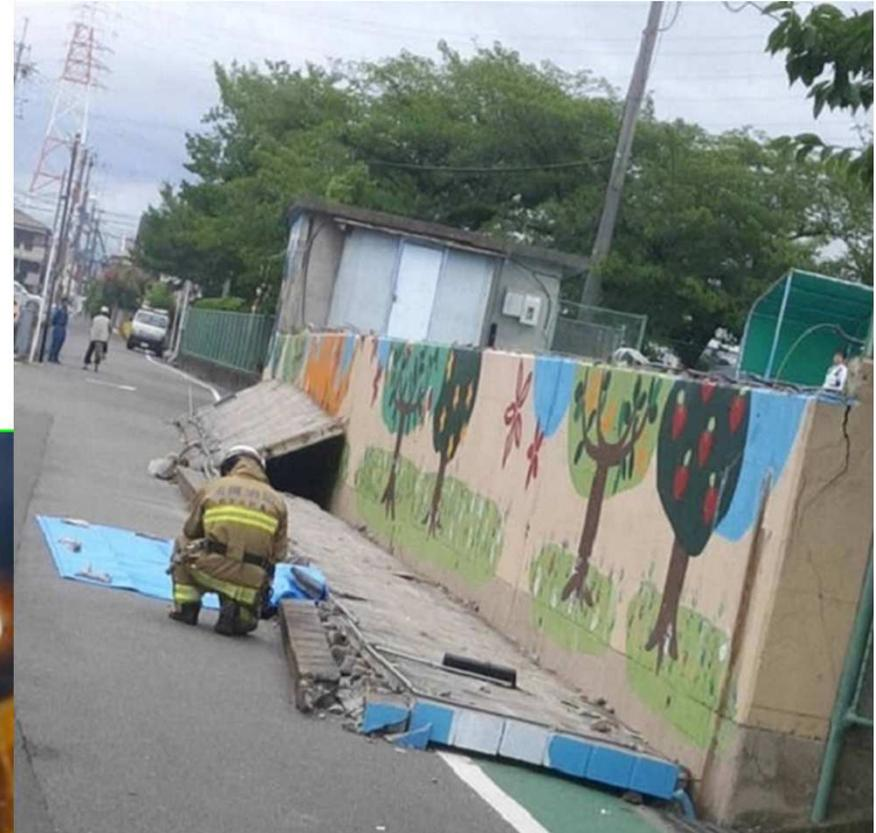
2018年6月 大阪北部地震で倒壊したブロック塀
