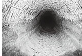
▲硫化水素による管路の腐食
