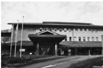
振興局の空きスペースを地区公民館や図書館分館、子育てセンターとして有効活用
