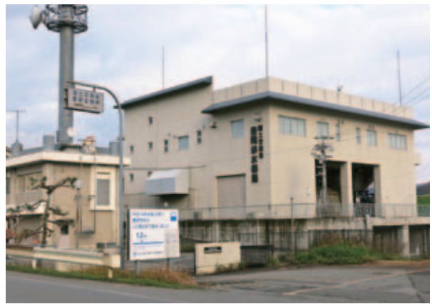
国土交通省 豊岡排水機場（排水ポンプ）
