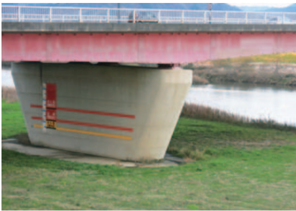
円山大橋の橋げたには洪水を予測するためのラインが引かれている
