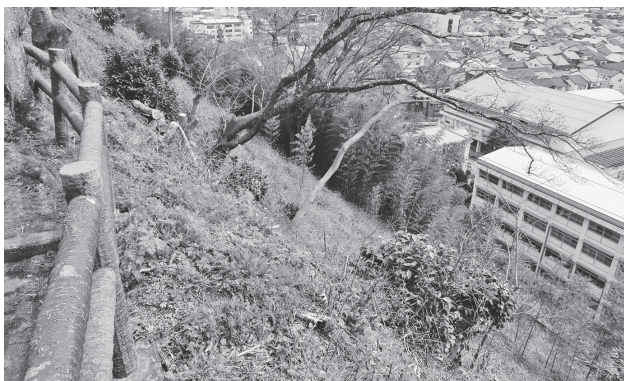
平成31年2月に土砂災害特別警戒区域に指定された神武山南側斜面
