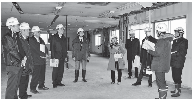
生涯学習サロン整備予定建物の現地調査(2階)
