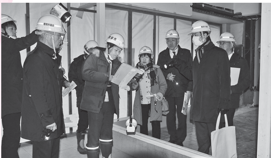
生涯学習サロン整備予定建物の現地調査 (1階)
