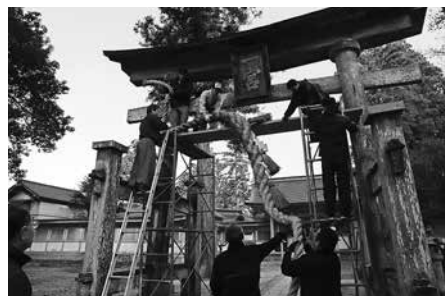
高さ4mでの作業
