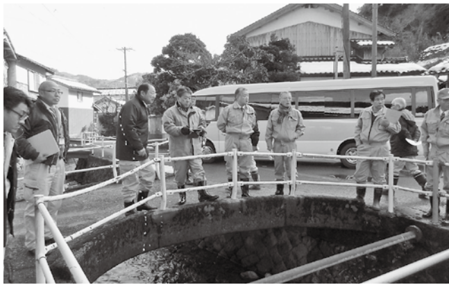
台風18号による土砂堆積のあった飯谷川（城崎）
