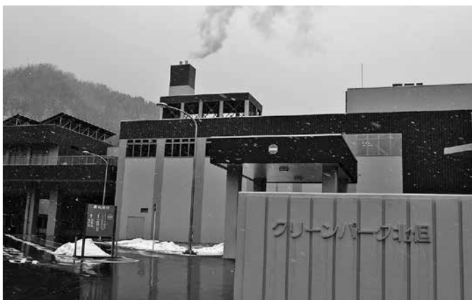
豊岡市、香美町、新温泉町が共同で運営する「クリーンパーク北但」
