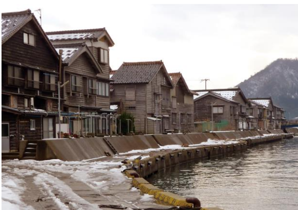
竹野地域：焼杉板を利用した町並み
