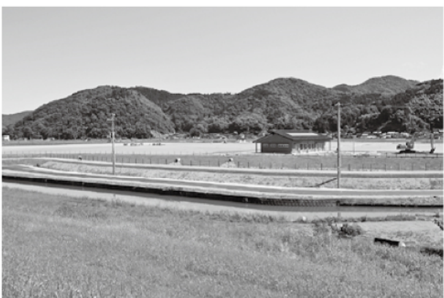
工事は最終段階に
