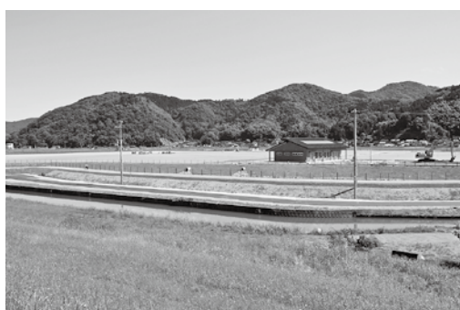
工事は最終段階に
