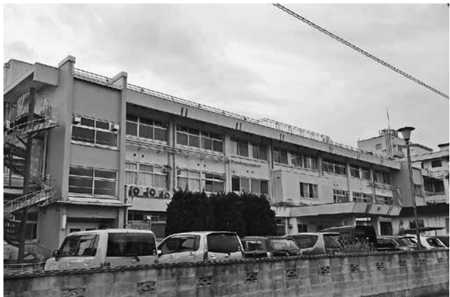
建て替えを待つ非耐震の本館（日高医療センター）
