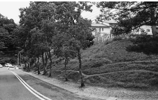
土砂災害警戒区域に指定されている通学路
