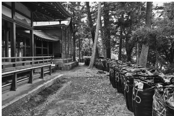
水害に備えて堤防のない神社の境内に置かれた土のう
