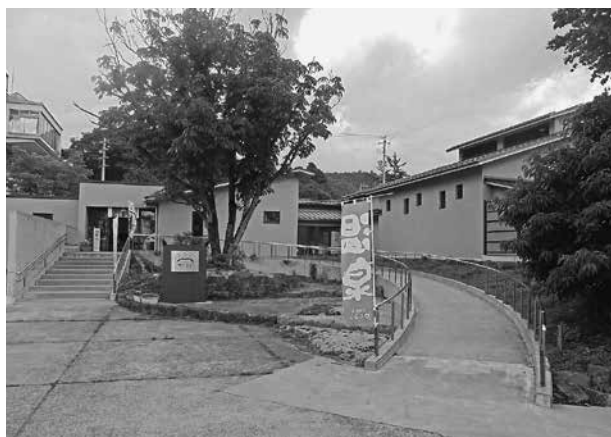
ペレットボイラー設置施設 (神鍋温泉ゆとろぎ)
