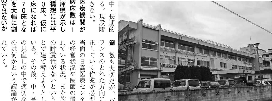
建て替えを待つ非耐震の本館(日高医療センター)
