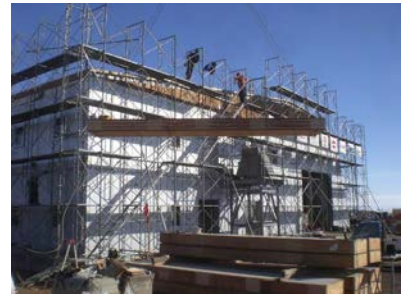
自然エネルギー棟屋根工事
