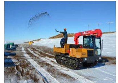
基地施設内除雪(砂まき)
