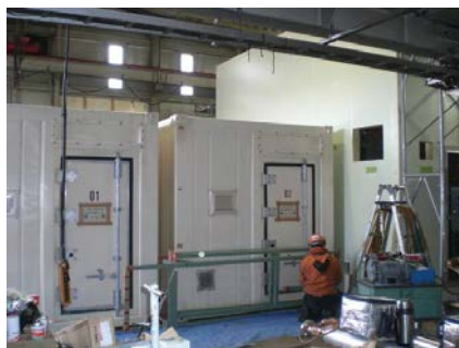
新汚水処理用コンテナ組み立て
