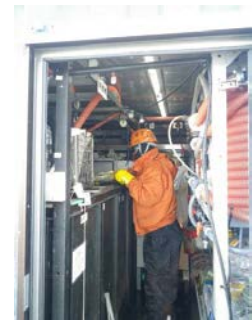
汚水処理装置定期確認
