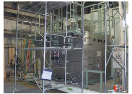
新汚水処理用タンク組み立て
