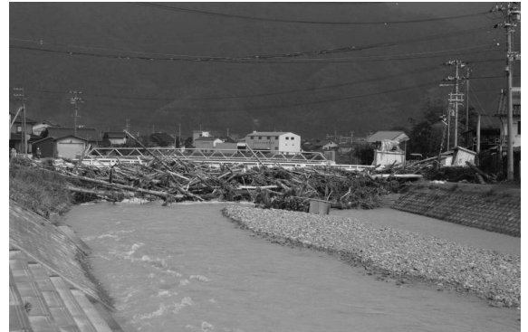
流木により川がせき止められる(出石地域)
