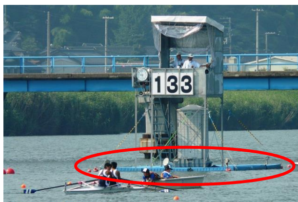
発艇台用浮棧橋
