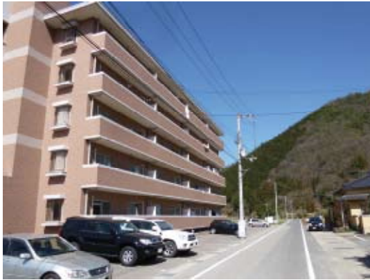
敷地境界からセットバックした大規模建築物
