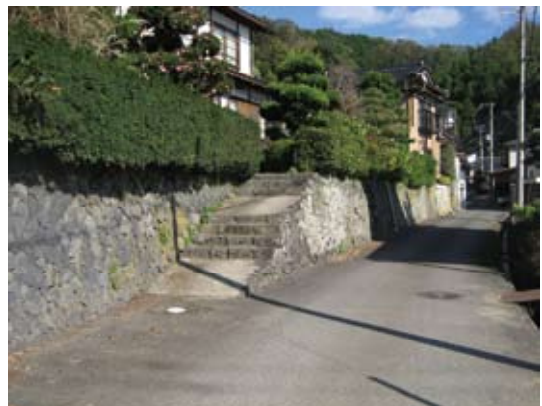
玄武岩を利用している石積み
