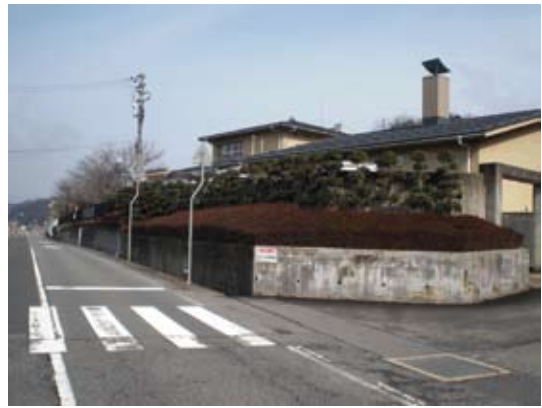
擁壁周辺に植栽された中低木
