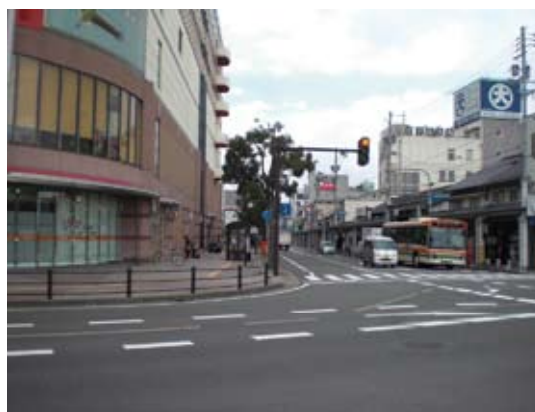
敷地境界からセットバックした大規模建築物
