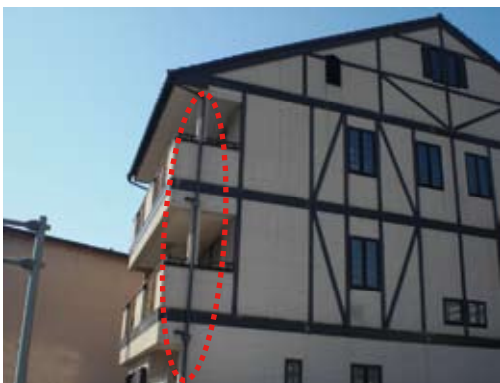
排水管を柱や梁と同色にする
