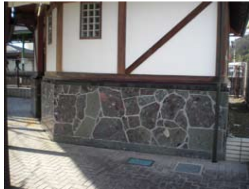
阿瀬子持ち石を使用した壁面
