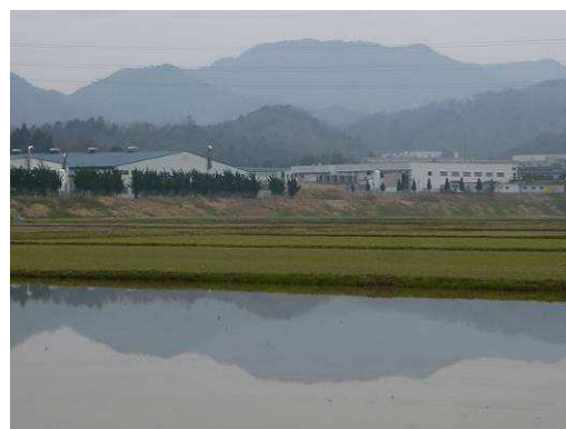
前面の田園や背後の山に溶け込む 豊岡中核工業団地
