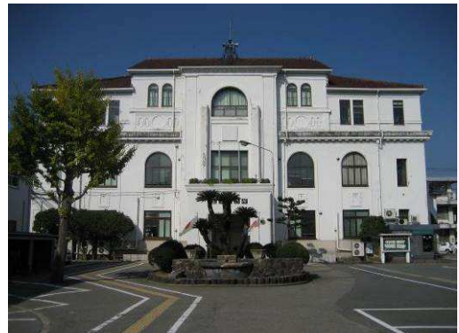
震災復興のシンボルである豊岡市役所旧本庁舎
