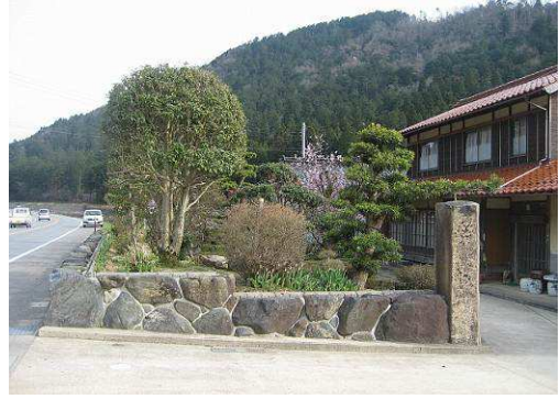
庭の石垣に利用されている蛇紋岩 (但東町正法寺)
