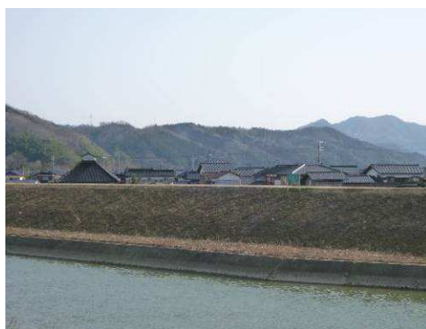
河沿いの屋根並み(下加陽)
