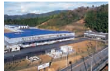
太陽電池の製造工場
