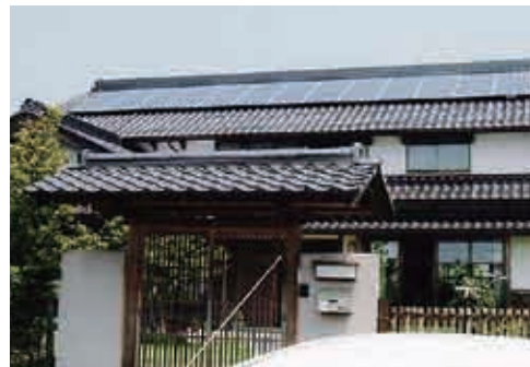
太陽光発電パネルを設置した住宅
