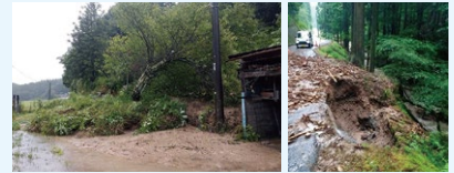
2023年8月に発生した台風7号により、本市も土砂崩れ等の被害が多く発生しました。
