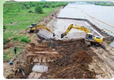
湿地創出など自然再生工事が進む河川
