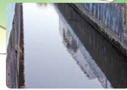
コンクリート水路は、ひっそりと水を運ぶ
