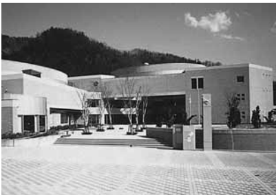
但東総合支所に24時間体制の救急を主体とした豊岡消防署の駐在所を設置
