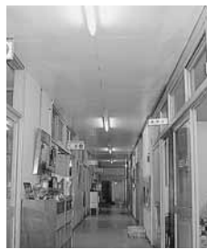
行われた城崎保育園の廊下空気濃度調査
