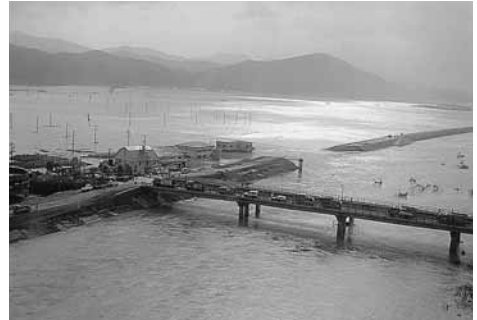
立野地区の円山川右岸の堤防決壊現場。立野大橋には救助のために駆け付けた緊急車両が並び、平成16年10月21日（写真提供：県消防防災航空隊）
