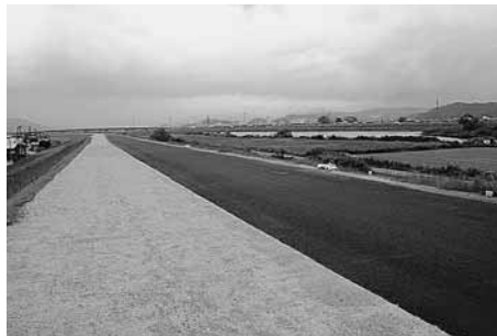
野上地区では、6月の出水期までに緊急的に堤防の高上げ工事が行われた
