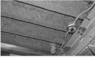
吸音・断熱材として天井に吹付け
