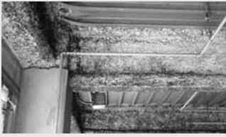
耐火用被覆材として梁に吹付け
