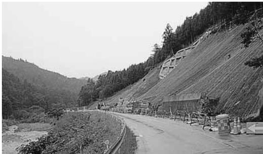
国道426号正法寺・平田間では、今も車線規制され、崩壊した山の修復工事が進められている
