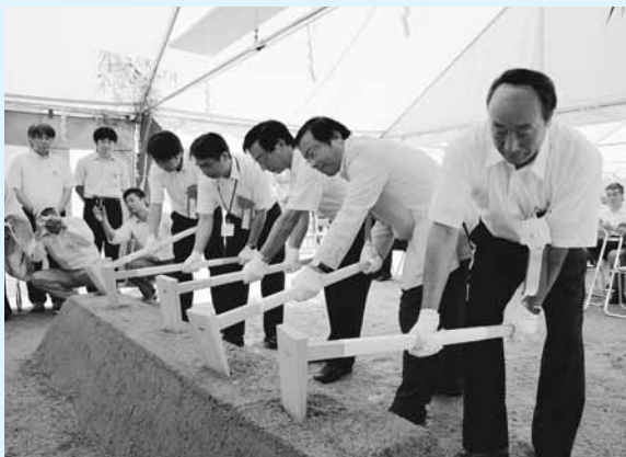
▲工事の安全を願い鍬入れを行う関係者。また、起工式終了後は、赤崎橋近くの治水祈念の碑に移動し、台風23号の犠牲者に事業着工の報告がなされた
