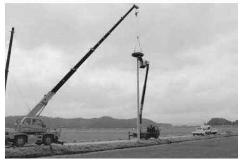
コンクリート柱に巢塔が乗せられ人工巢塔が完成した
