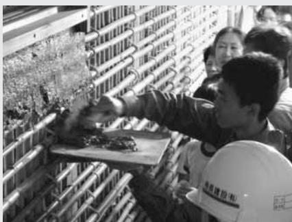
復原工事を自ら体験する参加者
