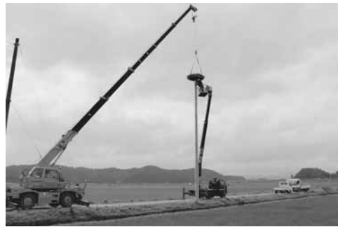
コンクリート柱に巢台が乗せられ人工巢塔が完成した
