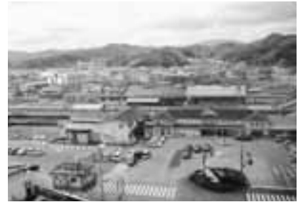
▲J R 豊岡駅舎のエレベーター設置と駅前広場の整備
