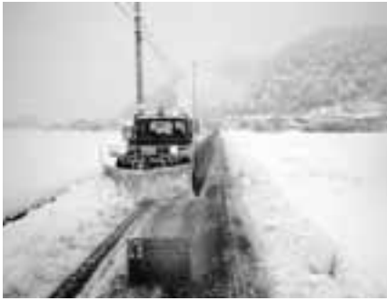
▲幹線道路の除雪をする除雪車(庄境)
