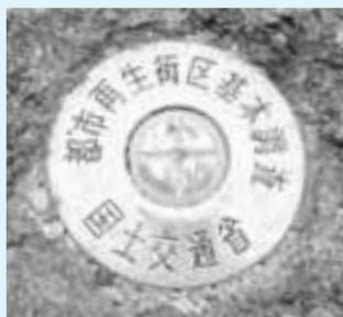
▲補助点(直径4cm・銀色アルミニウム製)
