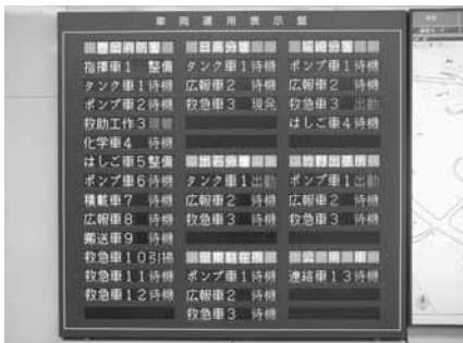
▲ 各消防車両の状況を表示します
