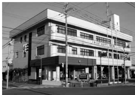
▲高機能消防指令センターを整備した消防本部（昭和町）
