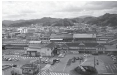
▲J R豊岡駅舎の移転と駅前広場の整備
