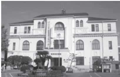
▲新庁舎建設の実施設設計を行い、仮庁舎へ移転(現市役所本庁舎)
