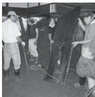
▲住宅に土砂流入
