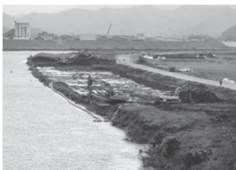
▲緊急治水対策事業が進む円山川
