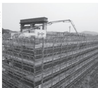
▲八代排水機場工事 (平成21年5月)
