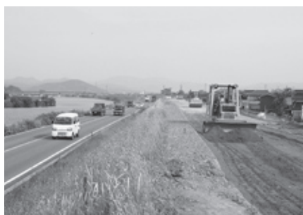
▲一日市区での堤防工事 (平成21年6月)
