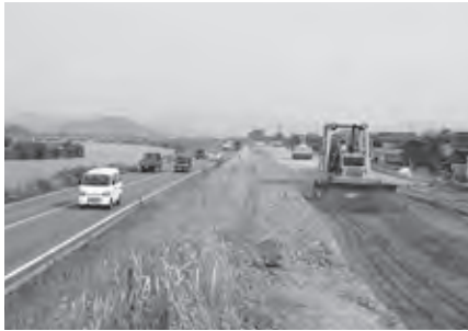
▲一日市区での堤防工事 (平成21年6月)
