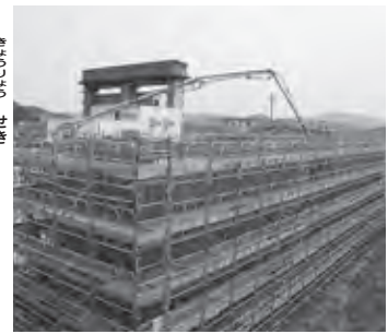
▲八代排水機場工事 (平成21年5月)
