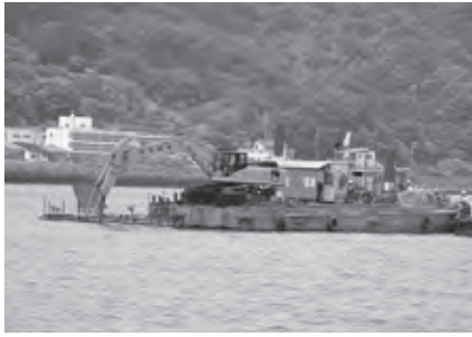
▲城崎町桃島区での河道掘削工事 (平成21年7月)
