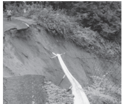
▲県道加悦但東線崩落(但東町赤花)
